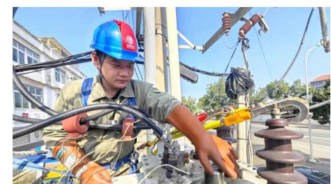
“A相、B相电压合格，准备测量C相电压……”11月15日，安山供电所工作人员对安山区5台10千伏变压器调档后的输出电压进行测量核实，为“迎峰度冬”安全供电奠定基础。
