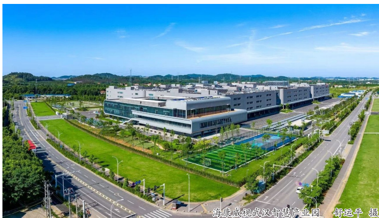
海康威视武汉智慧产业园 舒运平摄
