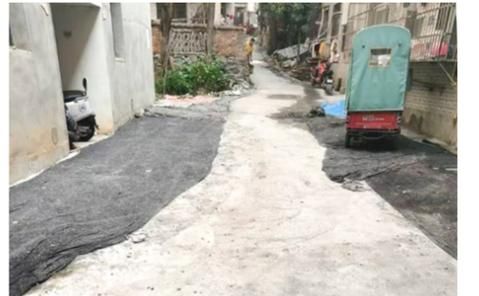
8月28日至9月8日，关山村党组织和村委会组织实施了关山村二组付家湾村湾道路硬化及附属设施完善工程。村“两委”全程统筹协调，严格把控质量与进度，投入32人次劳力、3台机械和52方混凝土，总投资3.2万元，历时11天，高质量完成了80米道路硬化及两侧附属设施、下水道的完善工作。通讯员 李彩凤 摄
